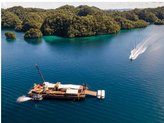
Figura I.3 - 2 – Pontone attrezzato (© Project Recover).
