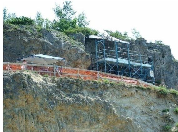
Figura 1.8 - Grotta Reali: il cantiere impostato nel 2005 (foto E. Rufo).
