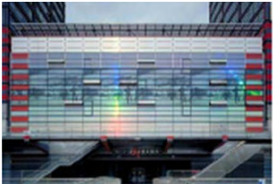
Figura 1.8: Vista della facciata con effetto di diffrazione della luce dovuto alla pellicola olografica
