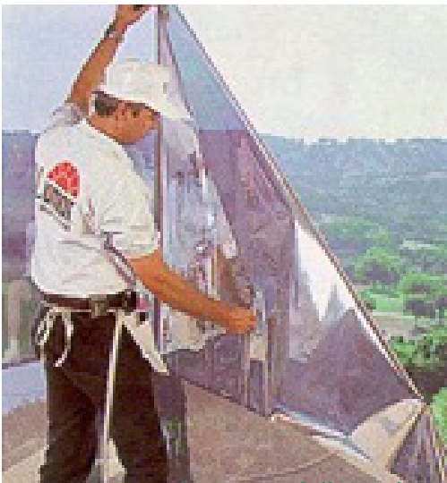
Figura 4.8: Applicazione delle tradizionali pellicole per vetri
