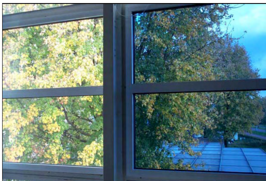
Figura 1.17: dettaglio di una delle finestre con controllo solare elettrocromico
