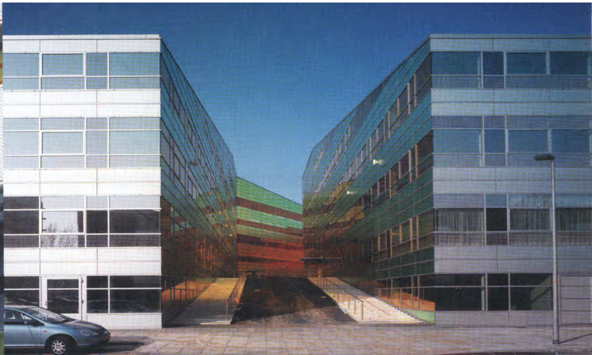
Figura 1.24: vista verso la corte interna
