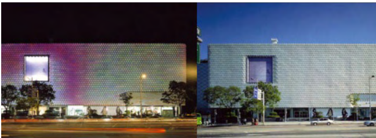
Figura 5.4: Edificio Galleria, colorazioni in diverse condizioni di luce
