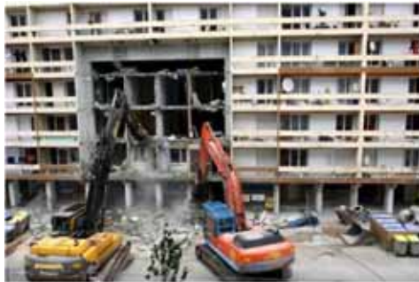
Figura 4.12 : 1. 2. 3. 4. 5. Immagini in successione delle fasi di demolizione parziale del volume finalizzate all'apertura di ampi varchi.
