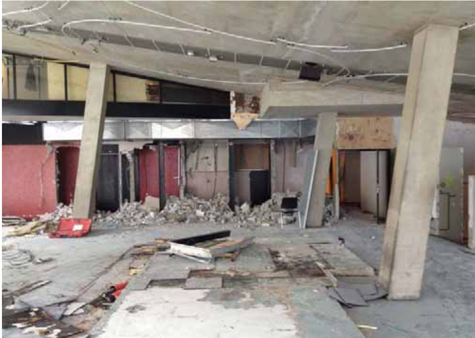
Figura 3.11 : Cantiere di riqualificazione della Kunsthal di Rotterdam, 2014. È lo stesso studio OMA ad occuparsi del progetto di riqualificazione, intervenendo per migliorare tutti i limiti che il progetto aveva evidenziato nel corso degli anni.
