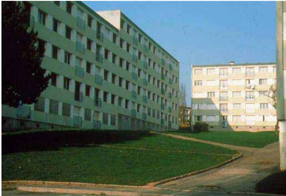
Figura 4.27 : L'edificio come si presentava prima dell'intervento.
