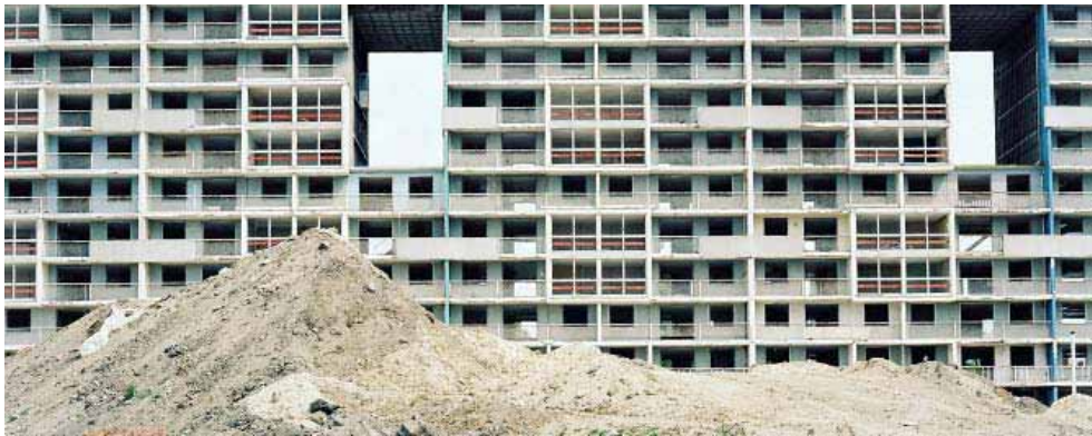
Figura 3.9 : Aperture nel volume dell'edificio Balzac, nonostante tale intervento di demolizione parziale, effettuato nel 1988, nel 2010 l'edificio verrà completamente demolito.
