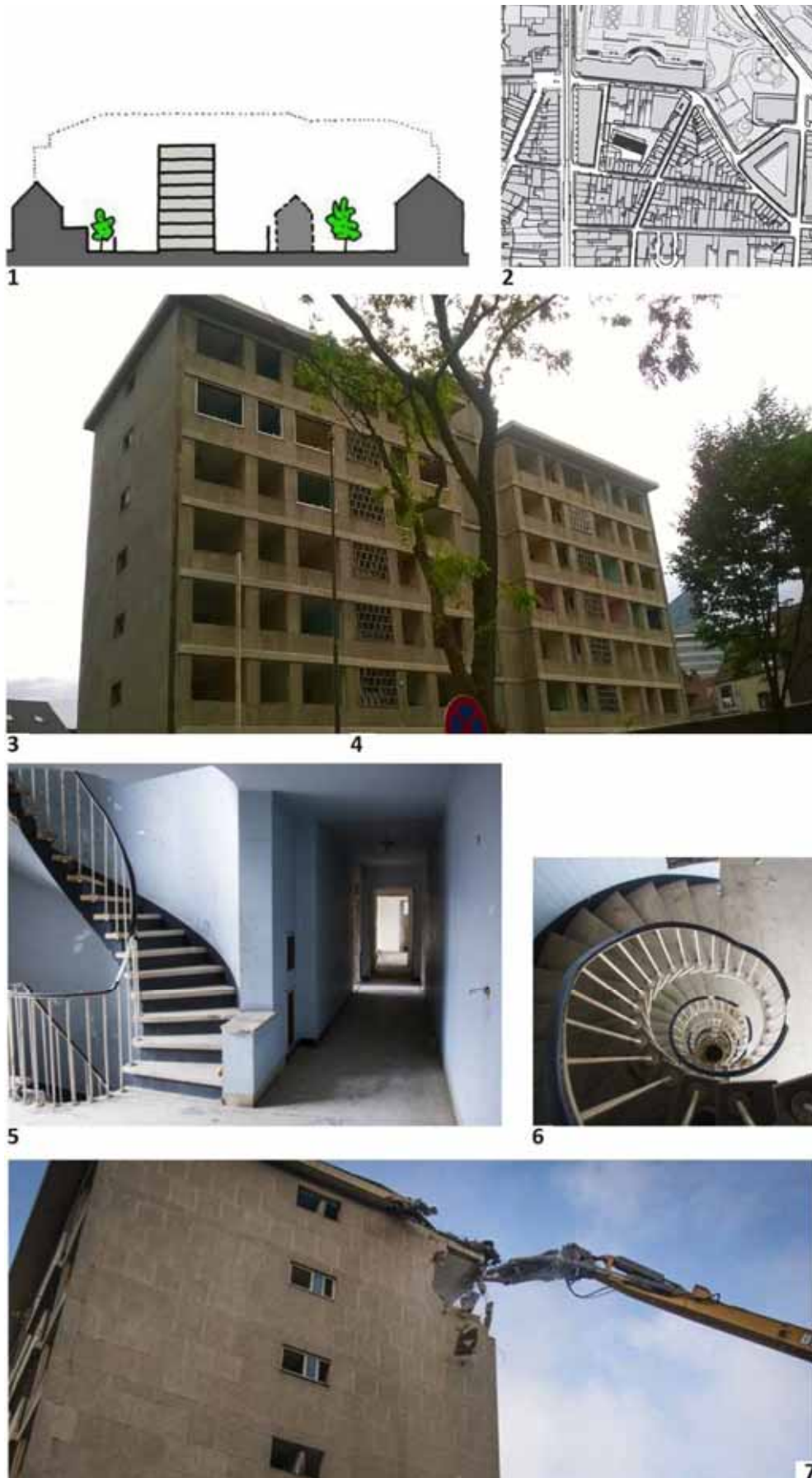
Figura 4.51 : Illustrazione dell'edificio pre intervento.
