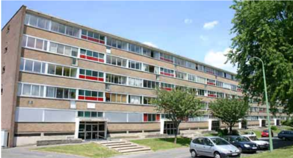
Figura 4.15 : Vista dell'edificio pre-intervento.
