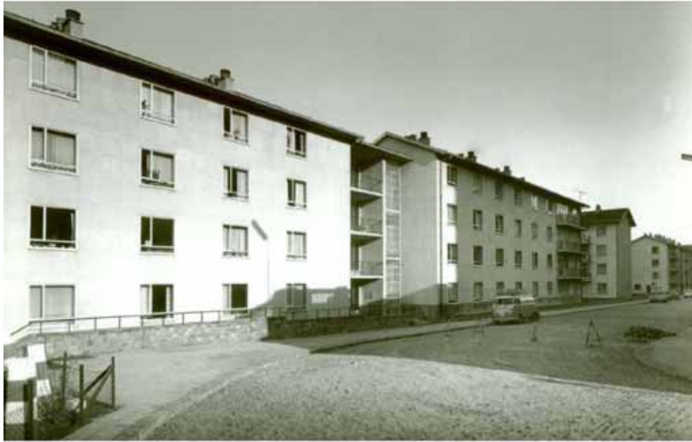
Figura 4.40 : Illustrazione dell'edificio originario e dello stato di fatto preintervento 1. Foto degli edifici appena ultimata la loro costruzione. 2. 3. 4. Foto degli edifici preintervento.
