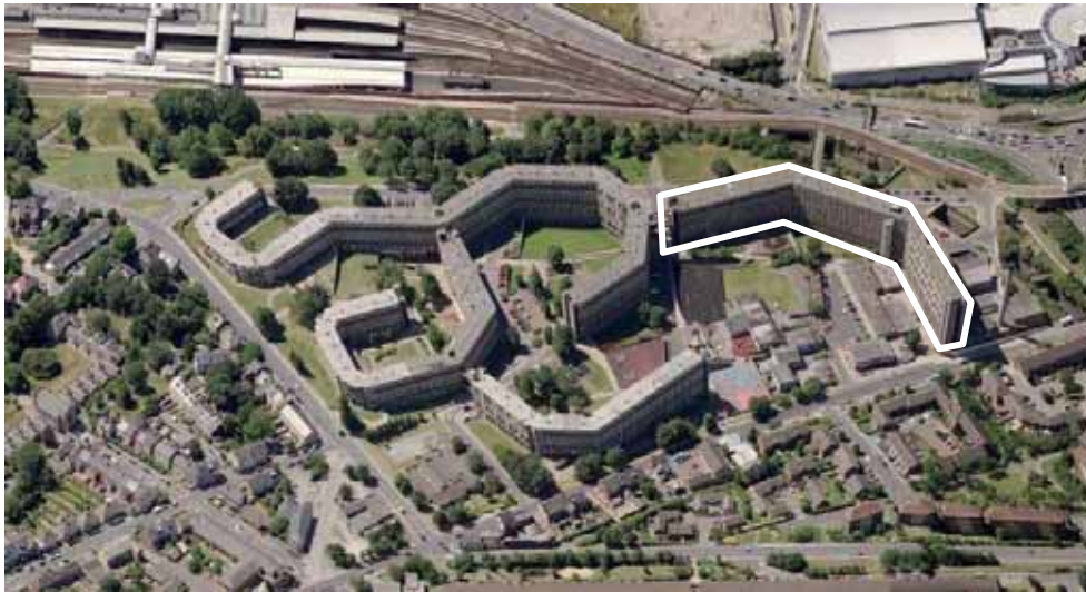
Figura 4.2 : Il complesso di alloggi sociali di Park Hill, a Sheffield, Gran Bretagna. Evidenziato, l'edificio riqualificato. (bing maps).
