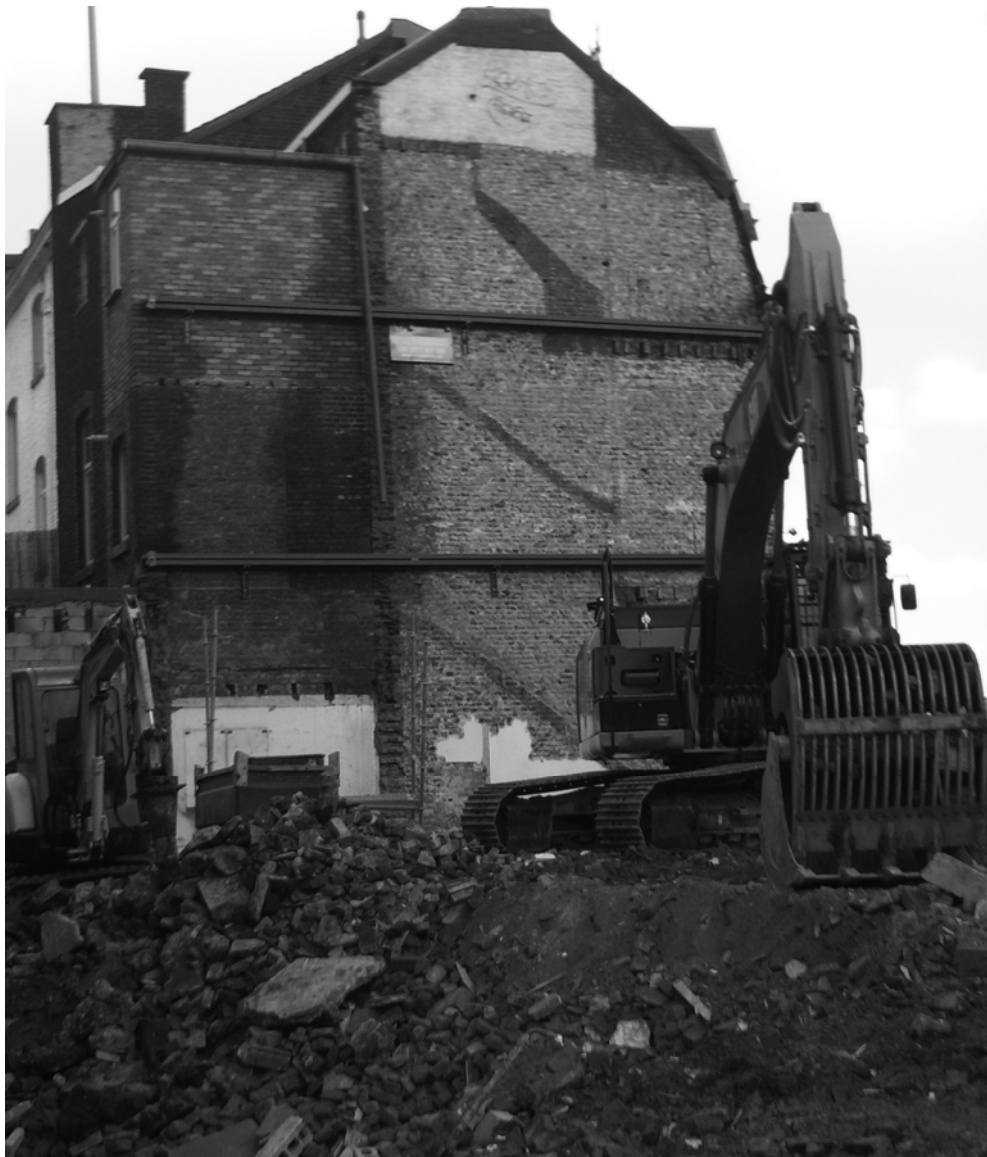
Figura 3.2 : Intervento di demolizione totale, Liegi 2013.
