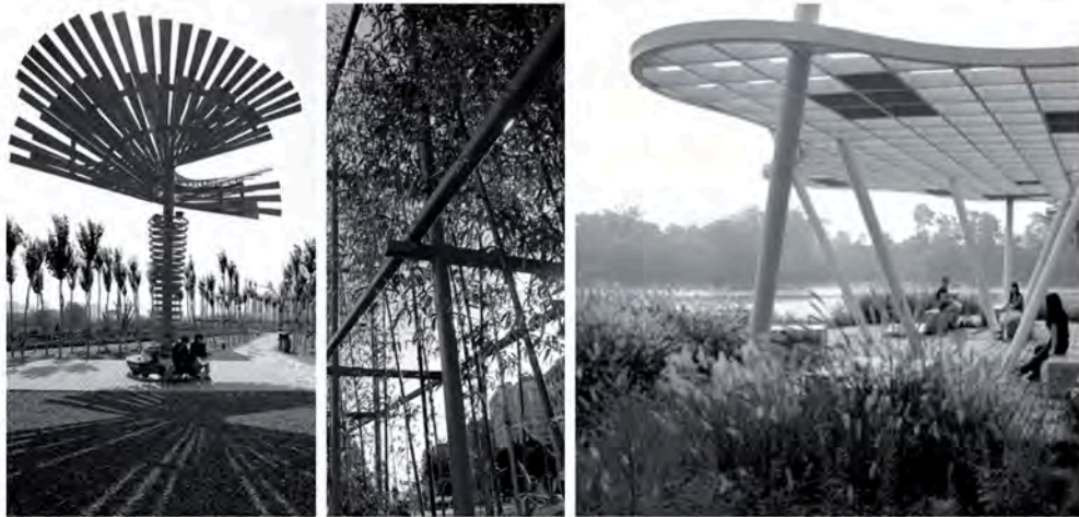
Fig. 11: le immagini descrivono alcuni dei sistemi tecnologici adottati per la protezione della radiazione solare (fonte: Turenscape)
