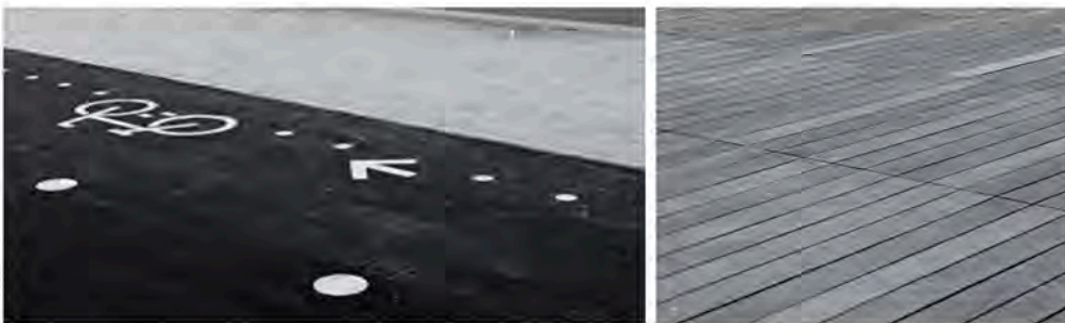
Fig 17: confronto tra differenti pavimentazioni del sistema antropico: a sinistra in primo piano una pavimentazione calda (asfalto), a destra una pavimentazione fredda (legno)
