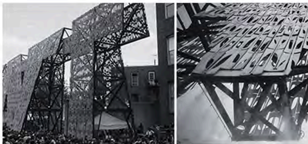
Fig 01: istallazione Party Wall , struttura generale e particolare sui nebulizzatori (fonte: YAP)
