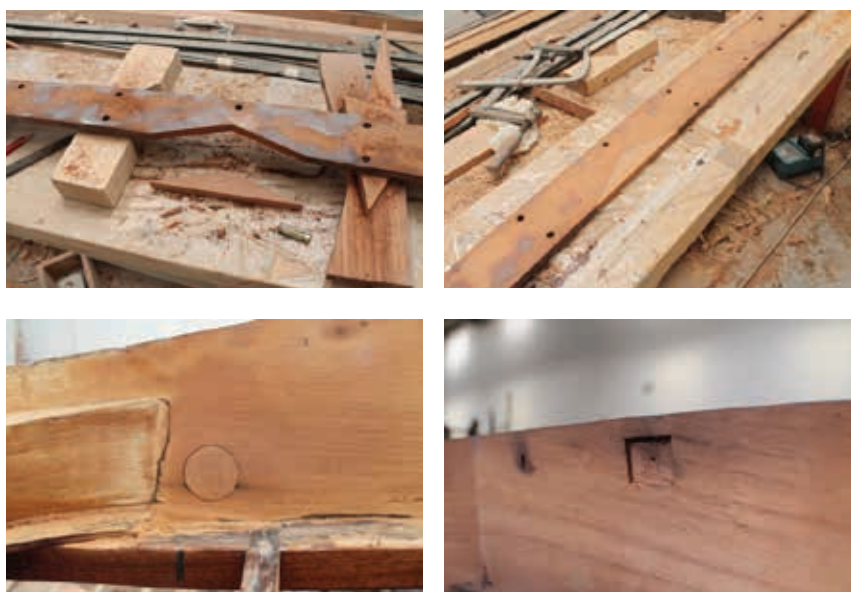
Diverse tipologie di tassellatura (T1) per il ripristino delle strutture. Spesso tali lavorazioni si rendono necessarie in corrispondenza dei fori delle ferramenta ove la fibra del legno risulta indebolita.
