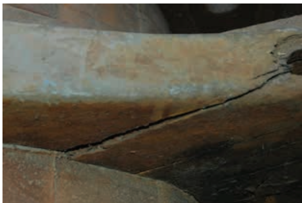
Fessurazione di uno dei madieri del fondo dell'imbarcazione.
