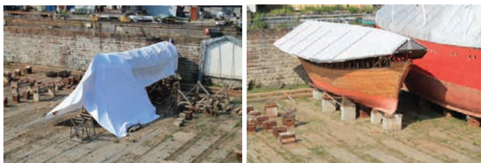
Figure 27 e 28. Esempi di coperture realizzate per il ricovero temporaneo di imbarcazioni in legno, in attesa d'interventi di manutenzione, all'interno di un bacino di carenaggio presso la fortezza marina di Suomenlinna (Helsinki).
