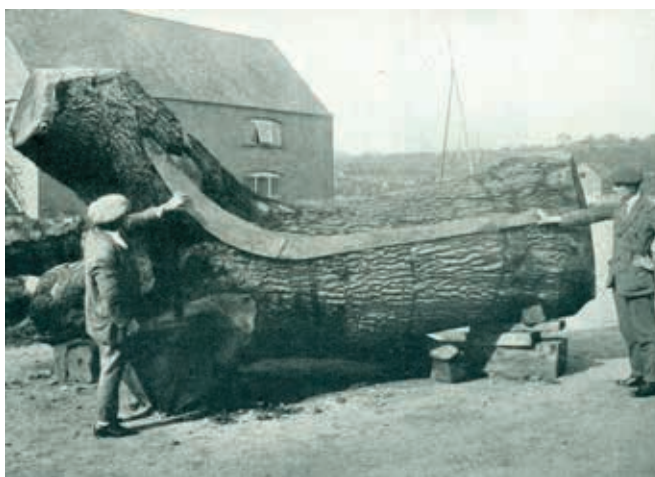
Figura 6. La presa di una sagoma per un elemento della chiglia di un'imbarcazione (Fox 1936, p.38).
