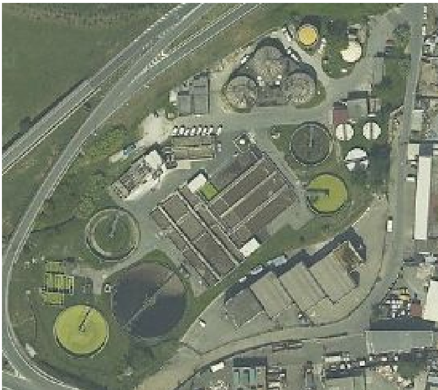
Figure 4.18.: La Spezia WWTP
