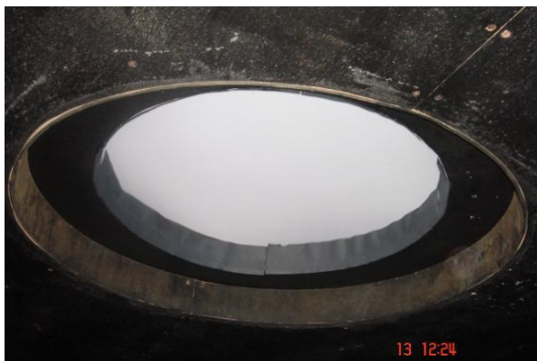
Figura 2.1. Vista dello schermo LCD dall'interno della struttura. ♣
