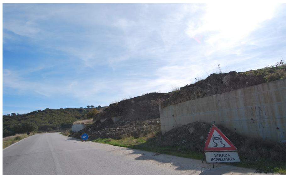
Fig. 7.12 – Attraversamento da parte della frana, che supera il muretto di contenimento in cemento, sulla S.S. 277.
