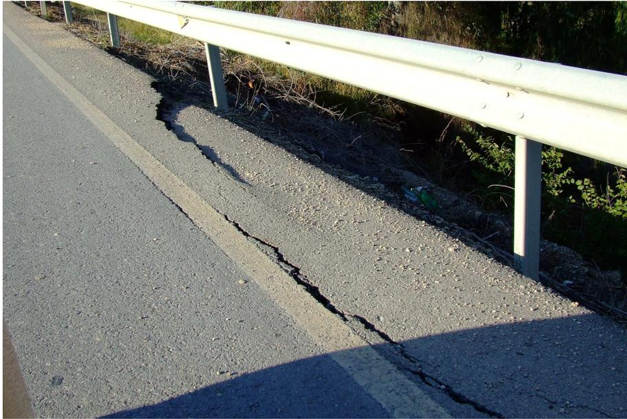
Fig. 3.18 – Tratto stradale nei pressi di Olvera interessato da cedimento di terreno.
