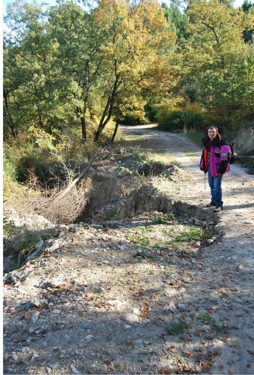
Fig. 7.2 – Nicchia di distacco laterale e scarpata secondaria.
